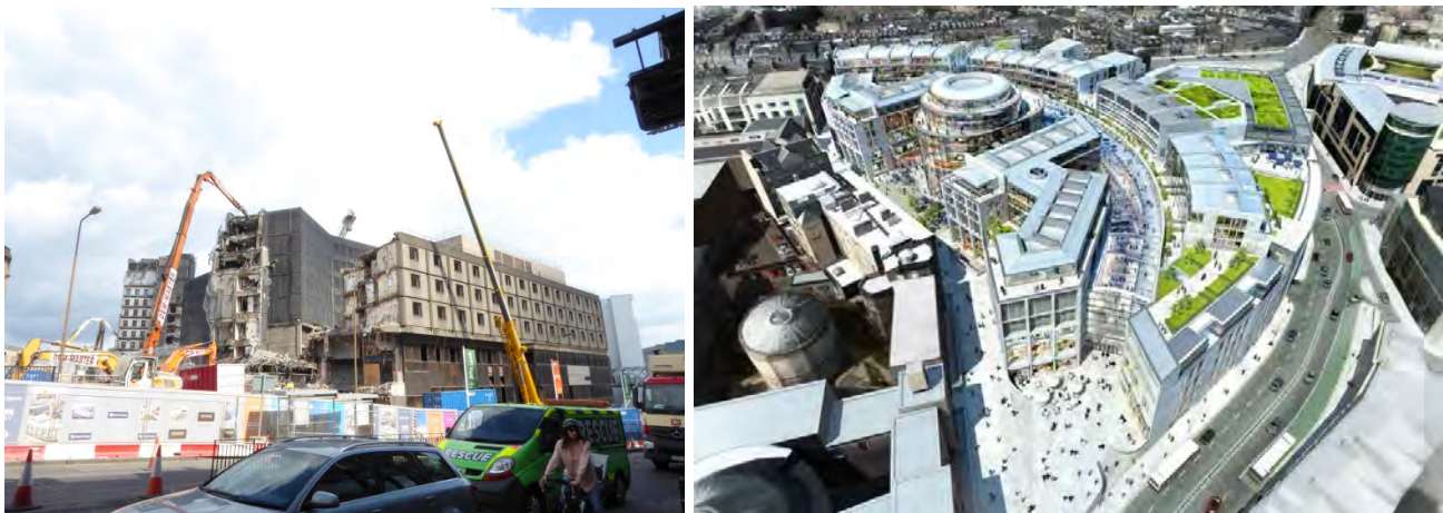
Démolition du St. James Shopping, rue Leith qui sera remplacé par le Edinburgh St.James Centre (en construction)
